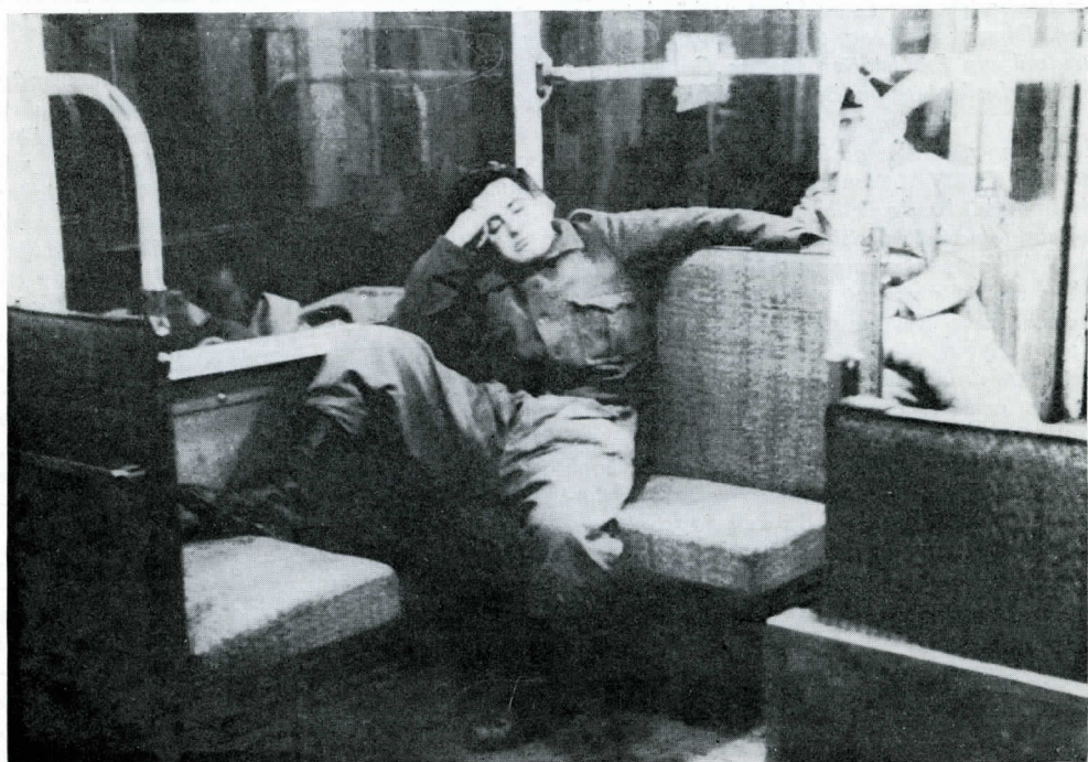
Metro Madrid – Station „Cuatro Caminos“, 1937
